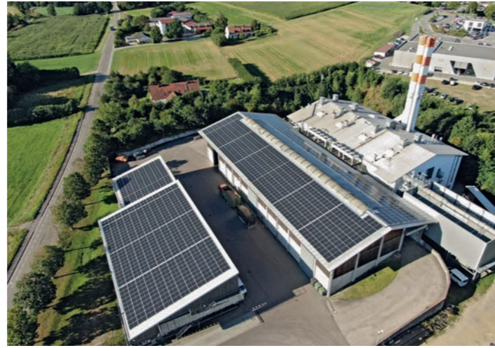
Unser Biomasseheizkraftwerk erzeugt jährlich etwa 40.000 MWh Strom und 54.000 MWh Wärme sowie 20.000 MWh Dampf. Mit diesen Energiemengen können mehr als 6.500 Wohnungen mit Heizenergie sowie 10.000 Wohnungen pro Jahr mit Strom versorgt werden.
